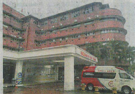
Pembinaan HSA2 dapat kurangkan kebergantungan serta kesesakan di Hospital Sultanah Aminah sedia ada.
